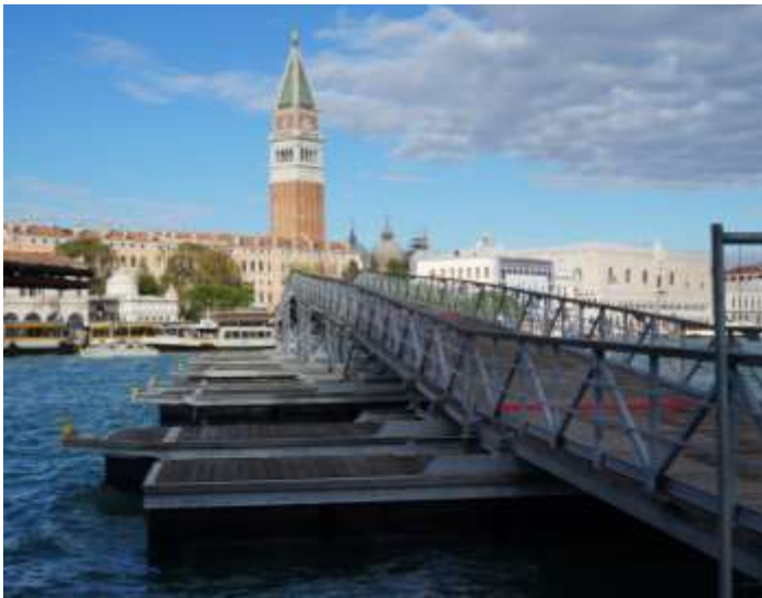
<大運河にかかる仮設の浮橋>
